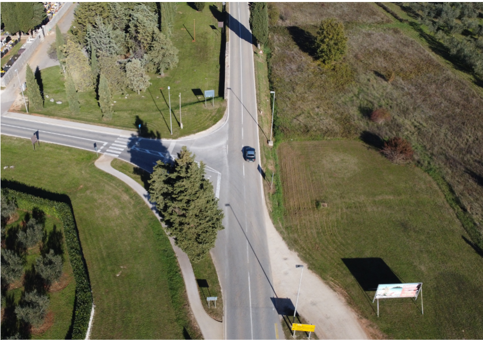
Slika 54. Raskrižje županijskih cesta Ž5209 i Ž5072 na ulazu u naselje Sv. Lovreč
